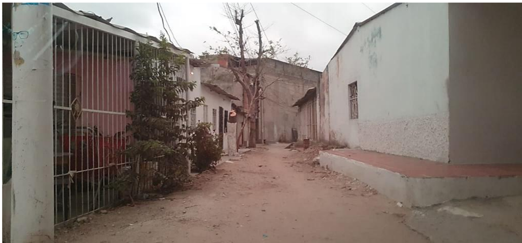
Fuente: fotografía No.1, tomada en la nomenclatura 63B en la primera visita, el día 02 de febrero de 2024, por el consorcio CONAUDIT 2023.
